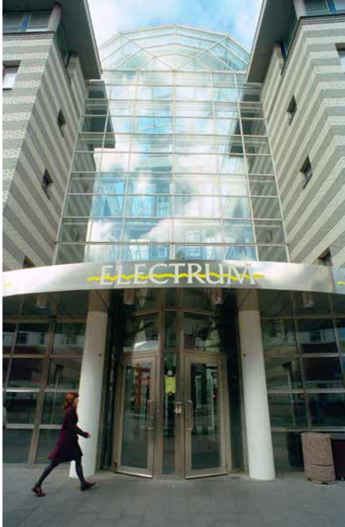
Electrums huvudingång placerades i öster medan andra byggnader i Kista hade sina i söder. Tyskt tegel på prefabricerad betongstomme, grå och vitrandiga fasad. Fönstren är som hål i muren med blå karmar och röda mittposter i djupa nischer.
