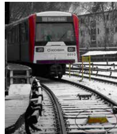
Hamburgs Tunnelbana med TagMasters läsare på spåret. Foto: Arkivet TagMaster
