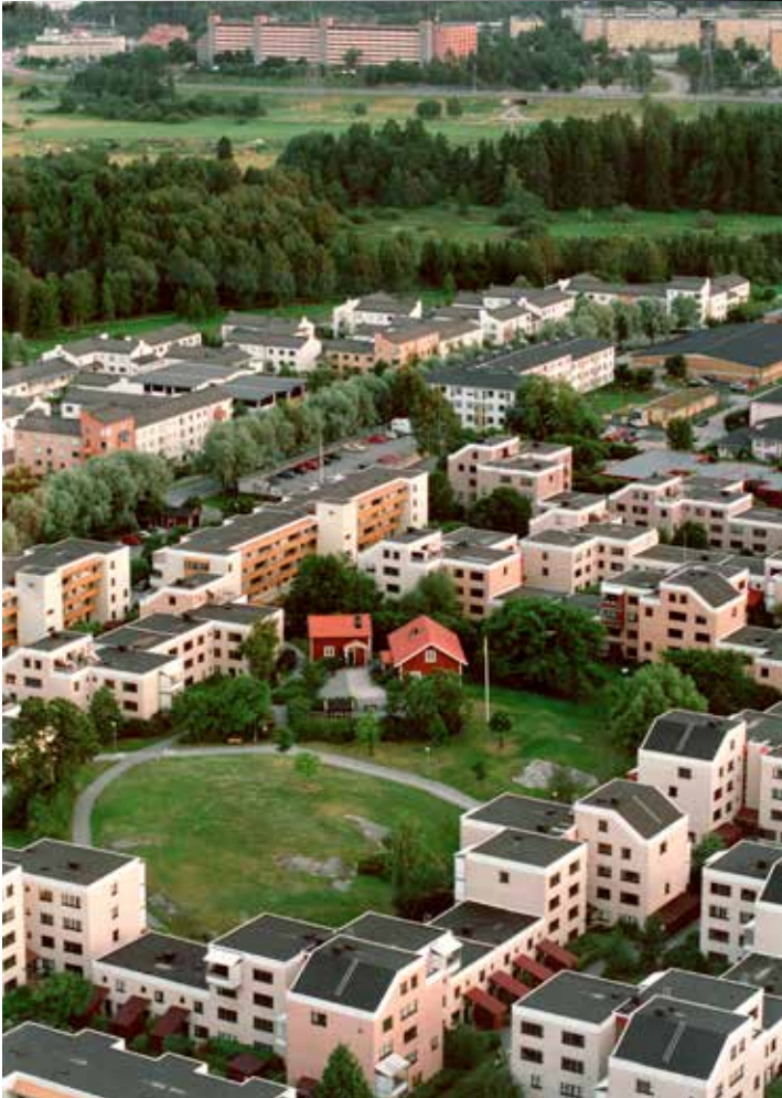
Ärvingedelen av Kista med Ärvinge gård och den rundade kulle där Ärvingekvinnan troligen hittades. Stjärnhus är punkthus med tre huskroppar som strålar ut från trapphusen i husets mitt. Deras svarta pulpettak ger Kista bostadsområde dess speciella karaktär, liksom de korrugerade plåtlisterna runt taken.
